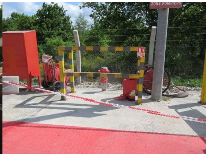
Poteau incendie non fonctionnel d'après le rapport de contrôle, à faire vérifier
