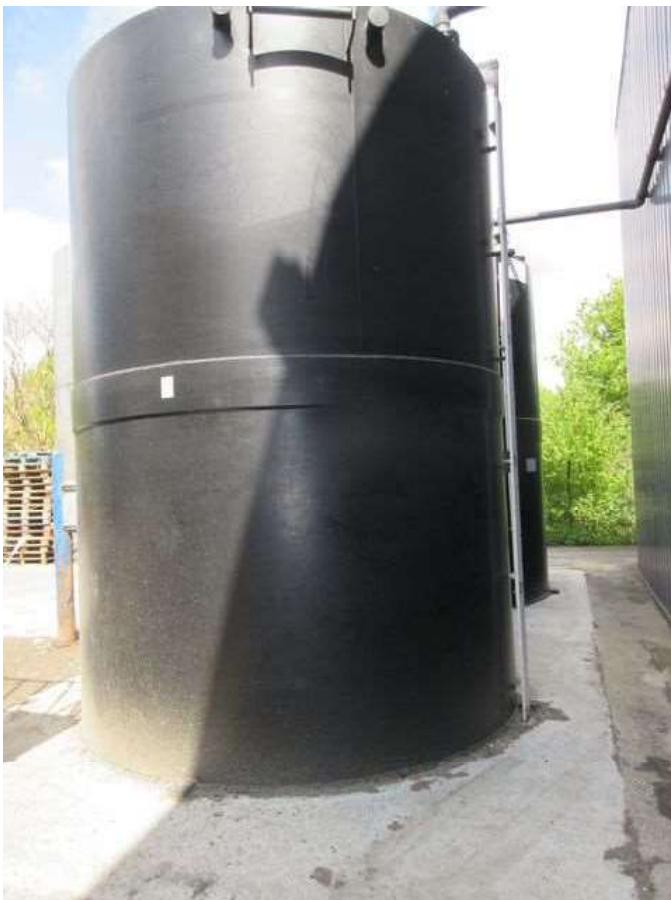
Cuves de rétention de 25 m 3 pour le process de tri des plastiques par flottaison
